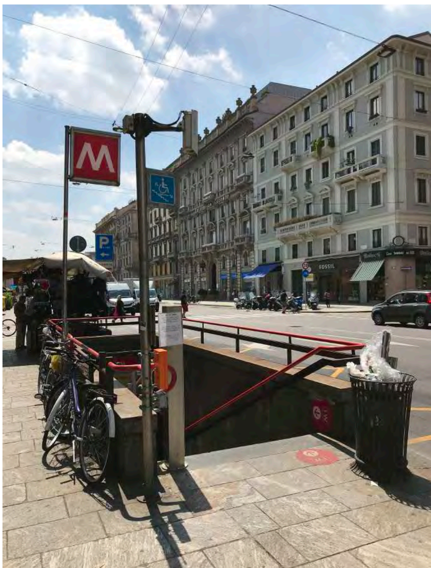
Stazione Porta Venezia, ingresso Corso Buenos Aires.
